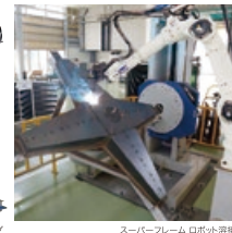
スーパーフレーム 口部外溶接
