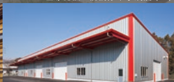
工場・倉庫 O社倉庫
