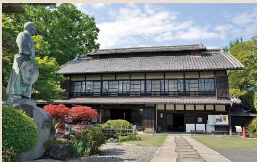
深谷市にある旧渋沢邸「中の家」 なかんち ©画像提供 深谷市
