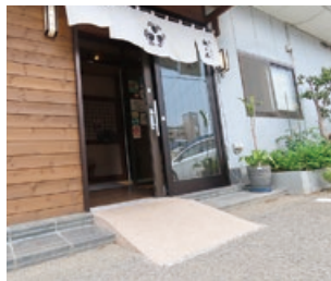
改装で設置したスロープで段差なく店内まで入れるように
