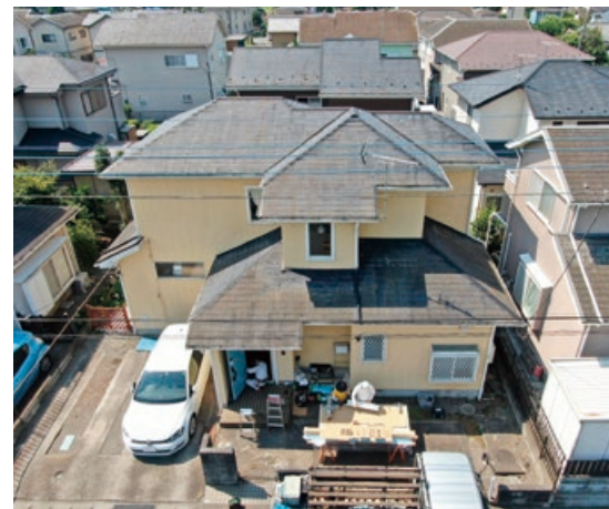
ドローンで撮影した現場
