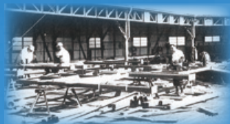
1958：製缶工場（現・鉄構部）
