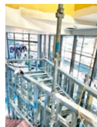
施工前（工事中）
