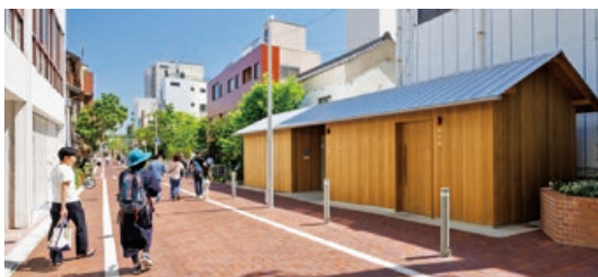
馬場川通り レンガ敷きでフラットに整備
