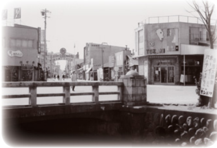
昭和 30 年代、諏訪橋より千代田通りを望む 千代田通りを挟んで向かって右側が立川町、左側が萱町
